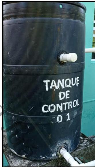
Figura 4. Tanques de control del agua residual.
