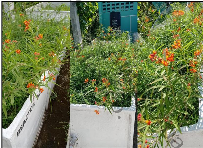
Figura 34. Humedal Artificial de Flujo Subsuperficial al final de proyecto.
