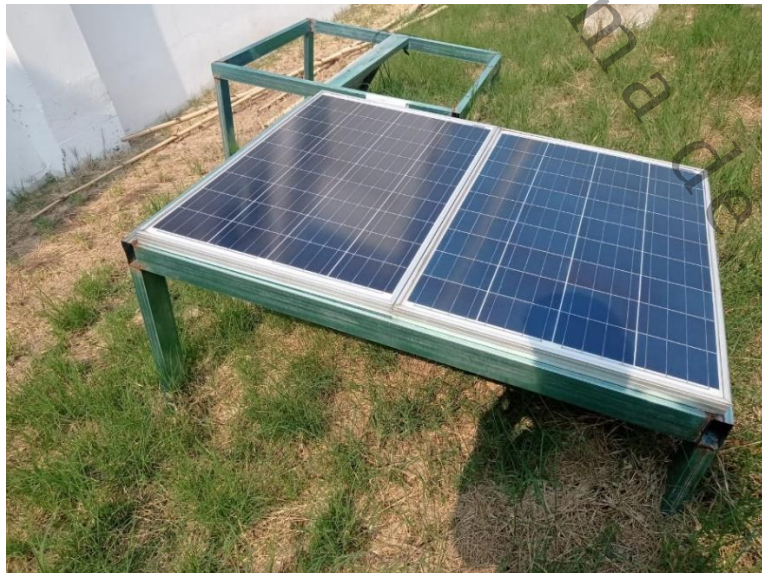
Figura 26. Instalación de soporte y panel solar en la DAIA.
