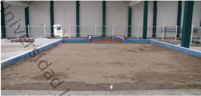
Figura 2. 19 Configuración inicial del área de estudio previamente compactada.
