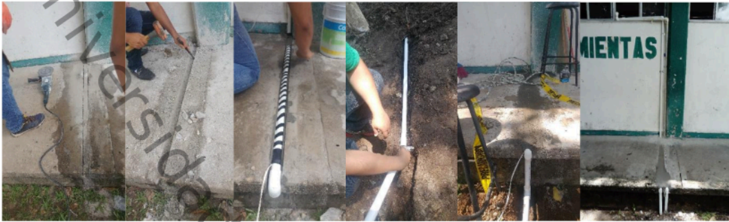
Figura 3.22. Proceso de instalación de tubería de instrumentación.
