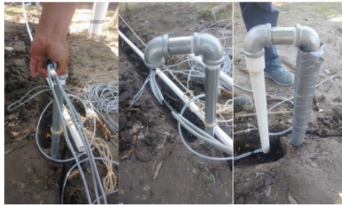
Figura 3.20. Instalación de la sonda.
