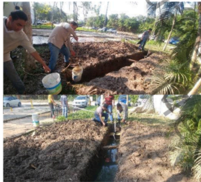
(c) Bombeo de exceso de agua
