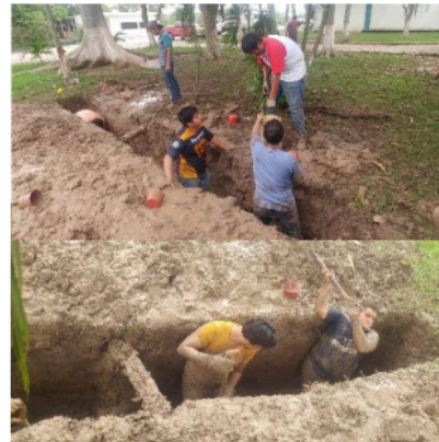
(b) Excavación a 0.75 m
