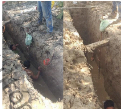
(d) Fin de excavación
