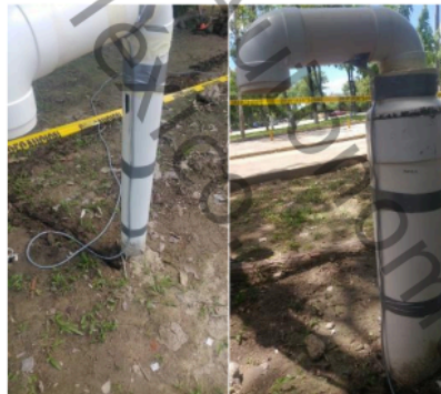
Figura 3.21. Colocación de los sensores de temperatura entrada y salida.
