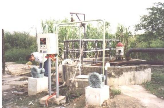
**Figura 24.-** Vista general de aireadores existentes en tanque de aireación en PTARD. Las Rosas.
