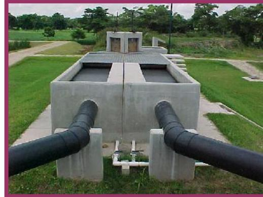
**Figura 43.-** Área de pretratamiento y desarenado PTARD Pantano Artificial de Villa Macultepec.
