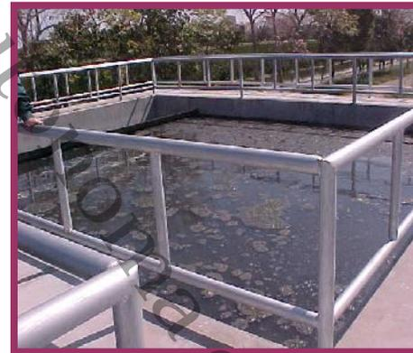
**Figura 45.-** Canal de salida del clarificador y compuerta para envío a celdas purificadoras.
