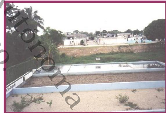
**Figura 33.-** Canal de salida de agua tratada en PTARD. KM. 15
