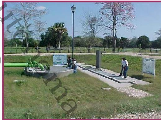
**Figura 49.-** Estación de bombeo de la Colonia Reforma. Cárcamo de bombeo de aguas residuales. Las aguas residuales solo se receptionan y son enviadas a un dren a cielo abierto.
