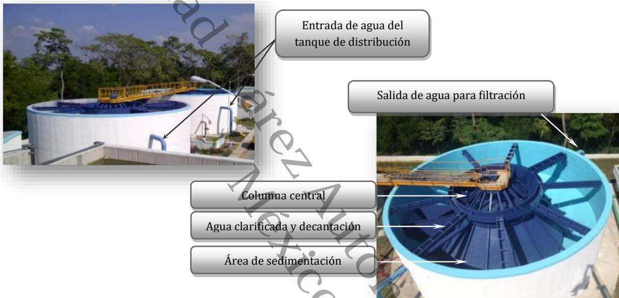
**Figura 6.** Componentes de una unidad de clarificación-floculación.
