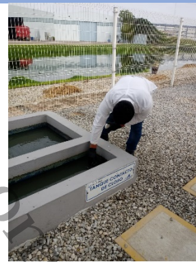
Figura A4. Toma de muestra Cloración.
