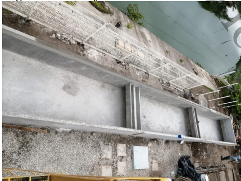
Figura A22. Construcción del tren de HA.
