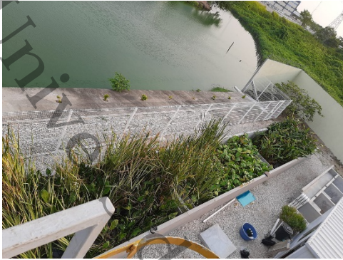
Figura A26. Tren de HA en operación..
