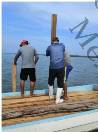
Figura 5: Instalación de postes
