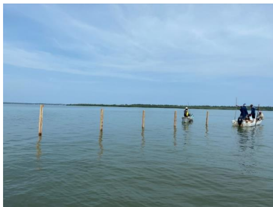
Figura 7: Instalación de postes cada 3 metros
