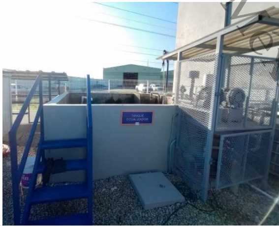
Figura A3. Tanque ecualizador.
