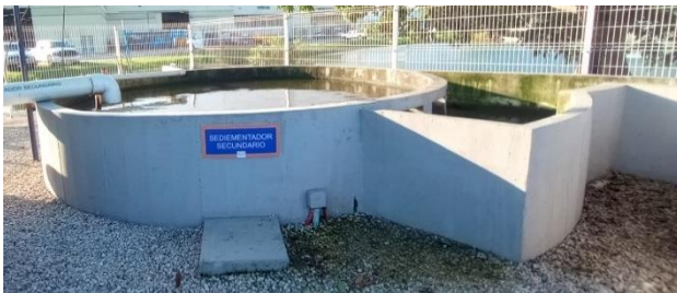
Figura A5. Sedimentador secundario
