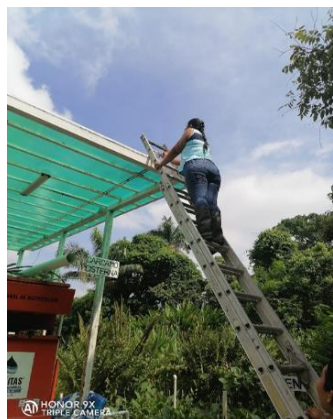
Figura 20. Mantenimiento de la techumbre.
