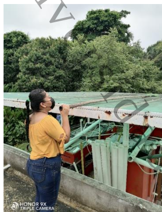
Figura 18. Limpieza y lavado del techo.
