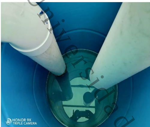
Figura 24. Colocación de pailería interna del tanque receptor.
