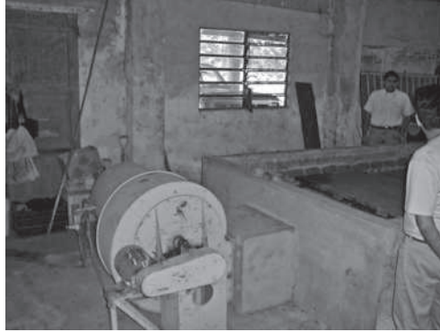
Figura 13. La boquilla se ha eliminado. La secadora es ahora de forma prismática. El punto de insuflación se ha ajustado atendiendo las dimensiones del ducto de descarga del ventilador.
