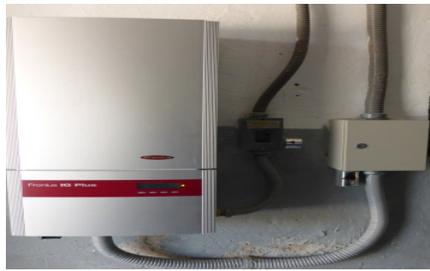
Figura 1. Inversor del sistema fotovoltaico.
