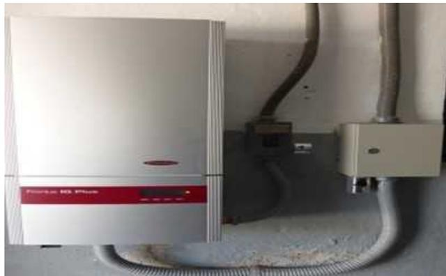
Figura 1. Inversor del sistema fotovoltaico.
