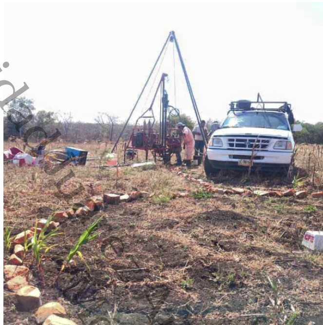
Figura 2.7: Trabajadores realizando una perforación.
