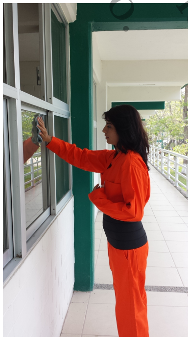
Figura 4.3: Actividad de limpiar ventanas de vidrio
