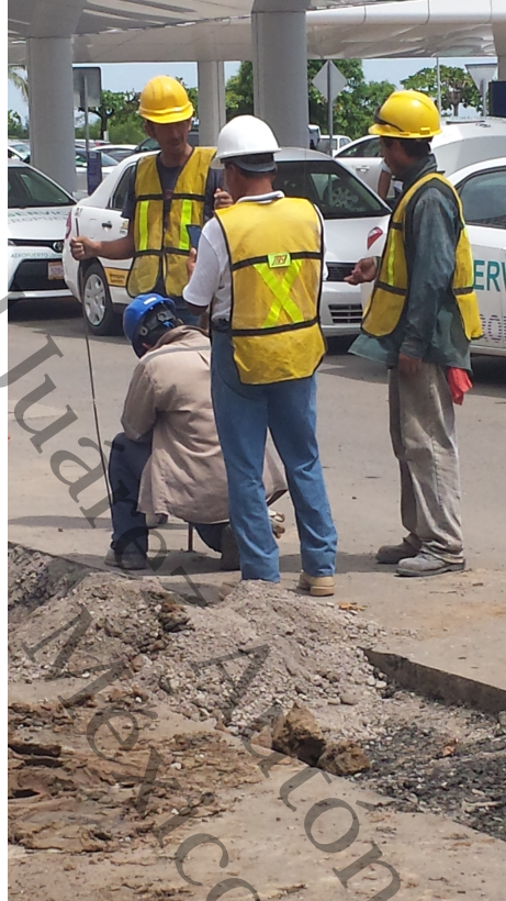
Figura 2.3: Trabajadores en asfalto.
