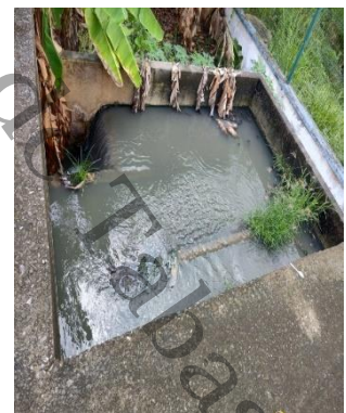
Figura 49. Lodos activados PTAR Paraíso-San Manuel.
