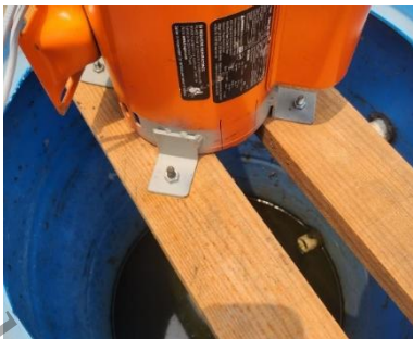
Instalación del agitador en la parte superior del tanque de distribución
