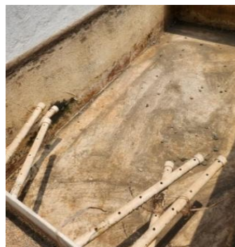
Vaciado de reactores
