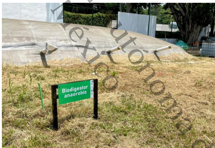
Figura 4. Biodigestor ubicado en área de CATRE- DACBiol.
