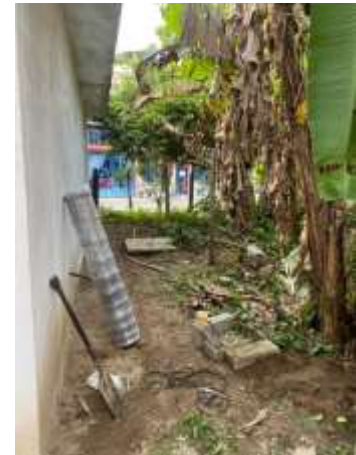
Figura 37. Adecuación del sitio.
