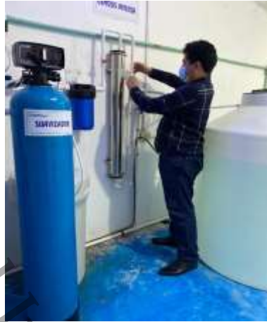
Figura 24. Sistema de Ósmosis Básico.
