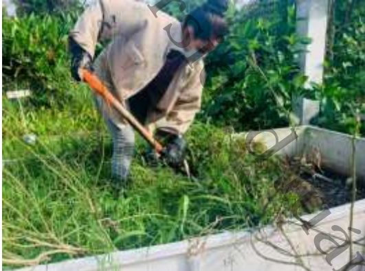
Figura 304. Mantenimiento de reactores. Fuente: FB Laboratorio del agua.
