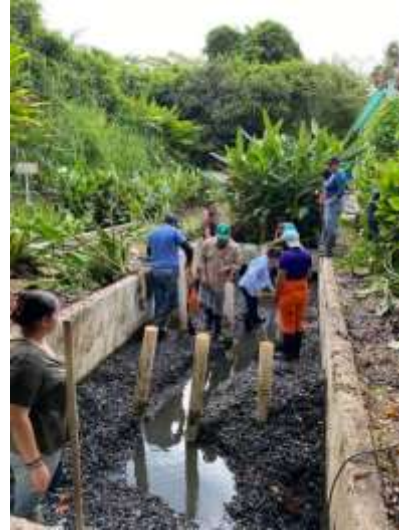
Figura 397. Cambio de medio de soporte. Fuente: propia.
