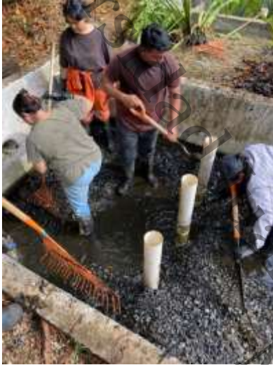
Figura 386. Mantenimiento de reactores. Fuente: propia.
