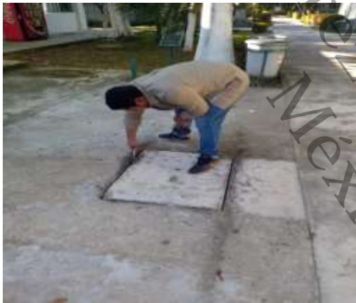
Figura 5 Apertura de registros. Fuente: Propia.
