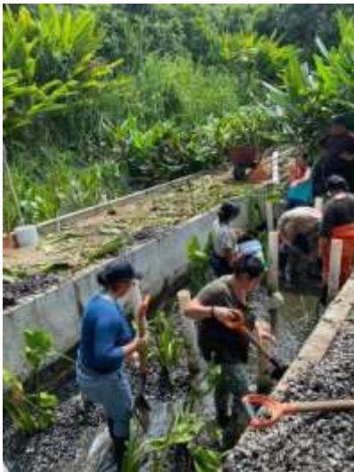
Figura 408. Mantenimiento constante de reactores. Fuente: propia.
