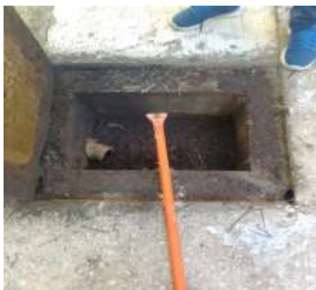
Figura 256. Registros Eléctricos. Fuente: Propia.
