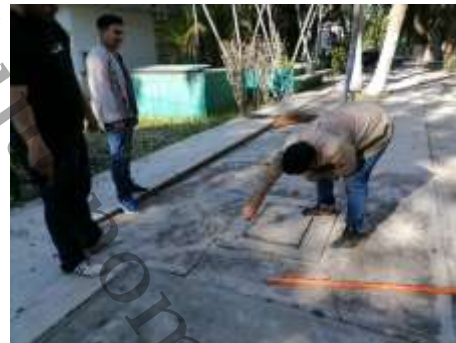
Figura 295. Inspección de las líneas existentes. Fuente: Propia.
