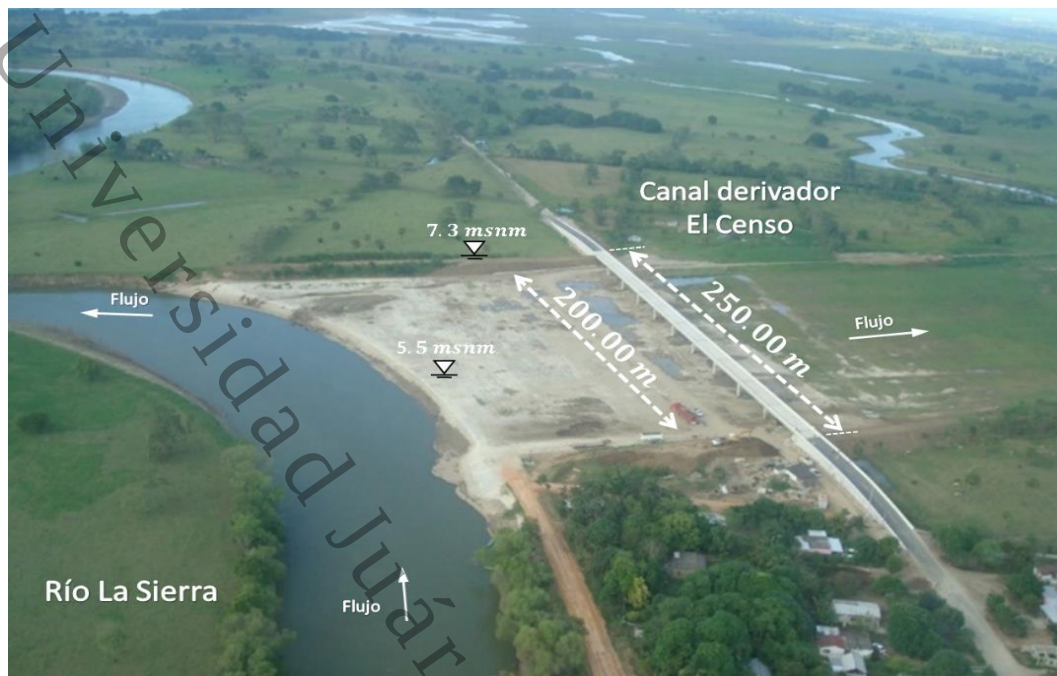
Figura 3.2. Canal derivador el Censo, en la margen derecha del río la Sierra.
