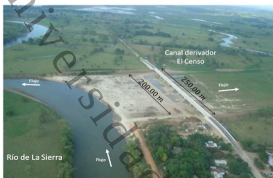
Figura 1. Canal derivador el Censo, en la margen derecha del río de la Sierra.
