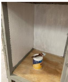
c) Proceso de pintado de paredes en el interior.
