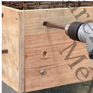
c) Fijado de la cimbra a la base soporte de los techos.
