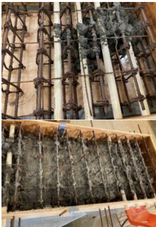
a) Vaciado de la mezcla de concreto.
