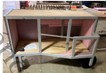
b) Proceso de aislamiento de las paredes en el interior.
