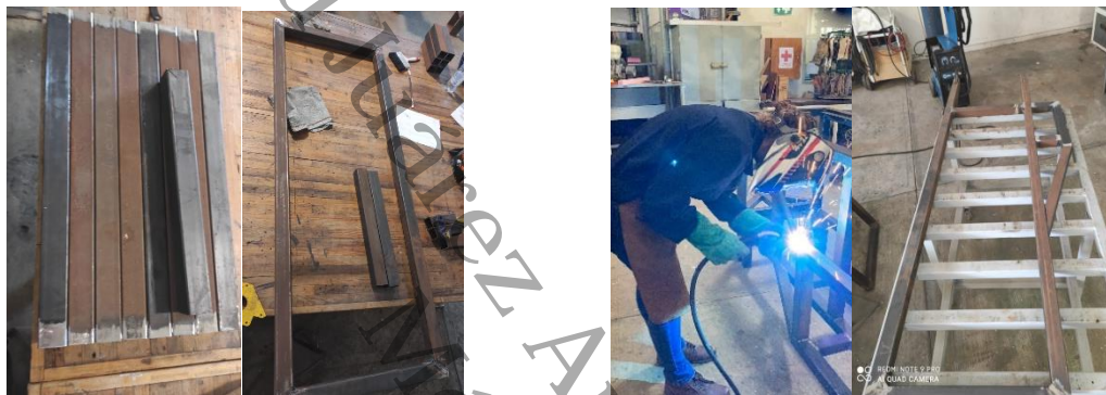
a) Corte de piezas y soldado de base superior
