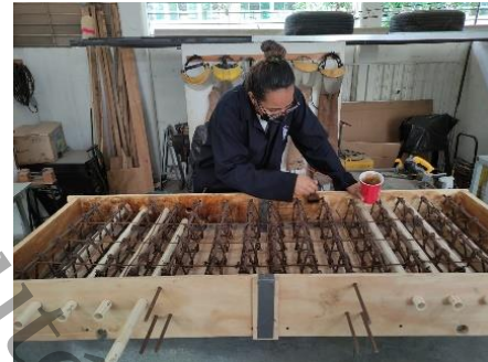
d) Recubrimiento de la madera.
