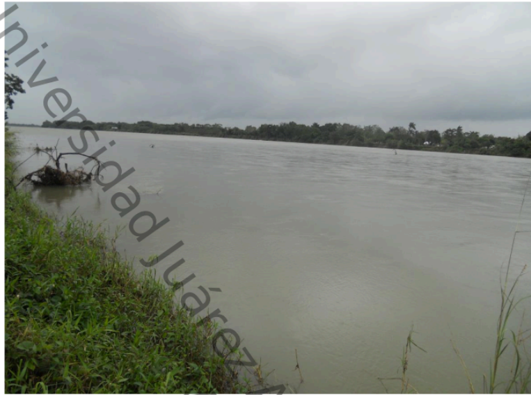
Figura 19 Margen Izquierda del río Mezcalapa (Zona de cruzamiento)
