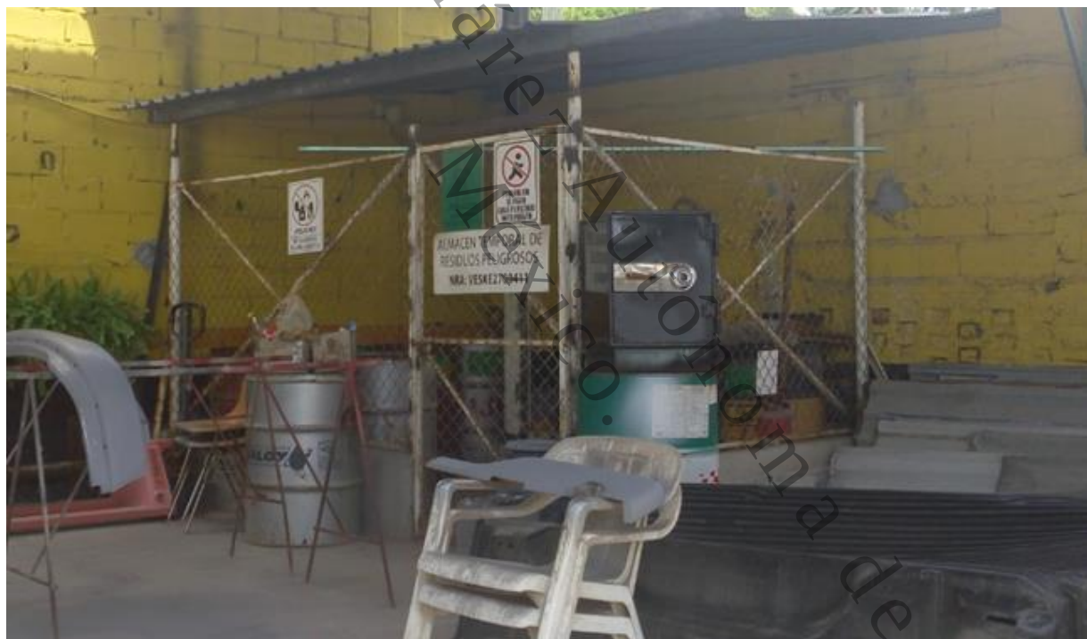
Figura 31 Almacén de residuos peligrosos que cuenta con casi el 100 % de las especificaciones que la ley emite.
