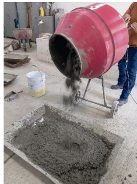
Figura 7. 64 Vaciado de la mezcla de concreto
