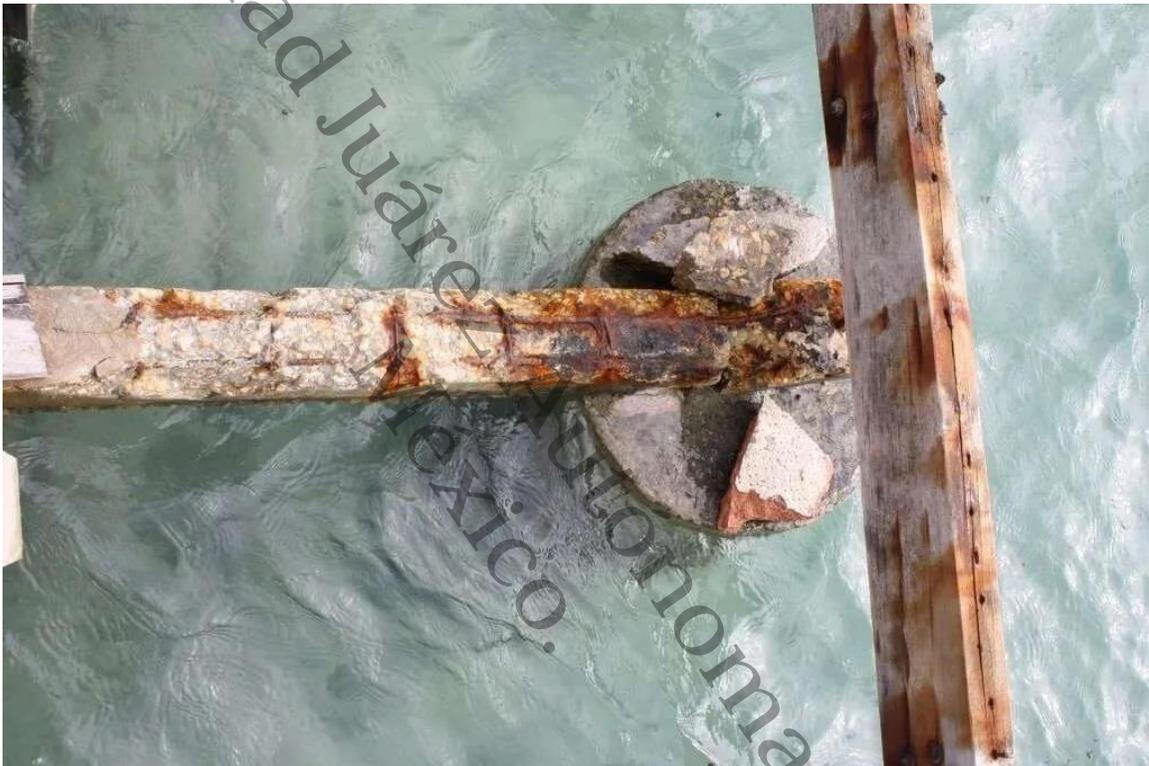
*Imagen 2.3 Ataque del sulfato en el concreto (LO QUE DEBES SABER SOBRE EL ATAQUE DE SULFATO EN EL CONCRETO - 360 EN CONCRETO, n.d.)*
