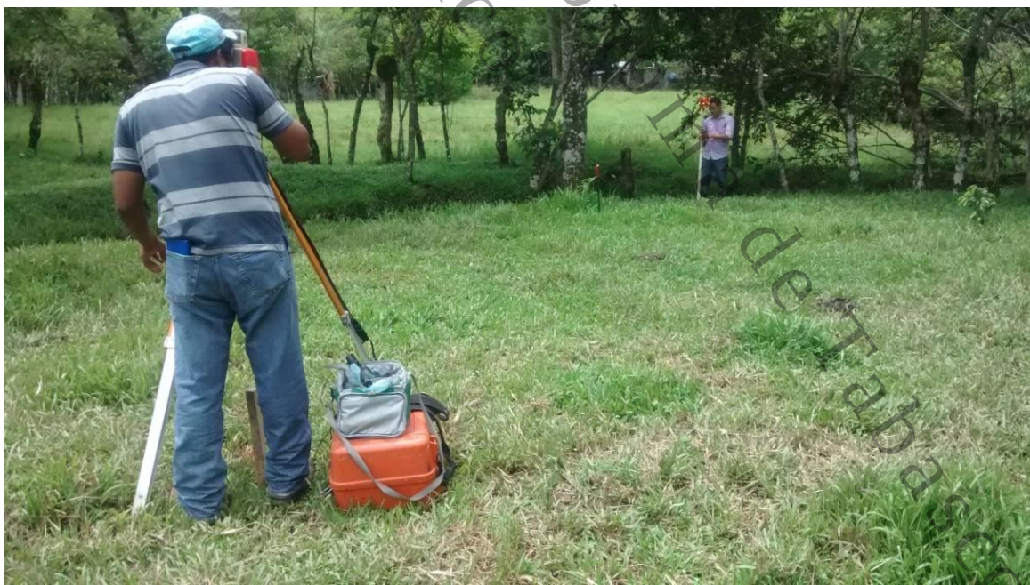
Fotografía 4: Seccionamiento del cauce, Estación 0+360.00
