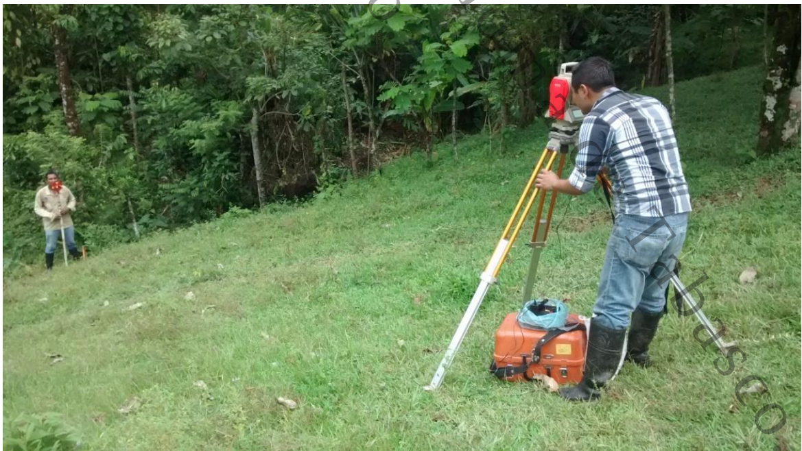
Fotografía 2: Trazo de la poligonal de apoyo, Estación 0+108.69
