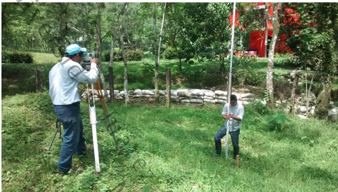
Fotografía 3: Nivelación diferencial de la poligonal de apoyo, Estación 0+220.00
