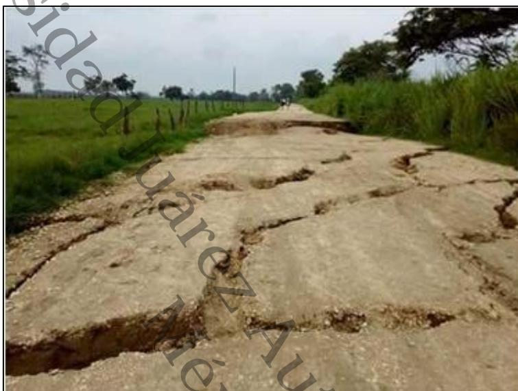
Figura 27. Asentamiento y desplazamiento en Acachapan y Colmena (Jesús de la cruz *et al.*, 2017).
