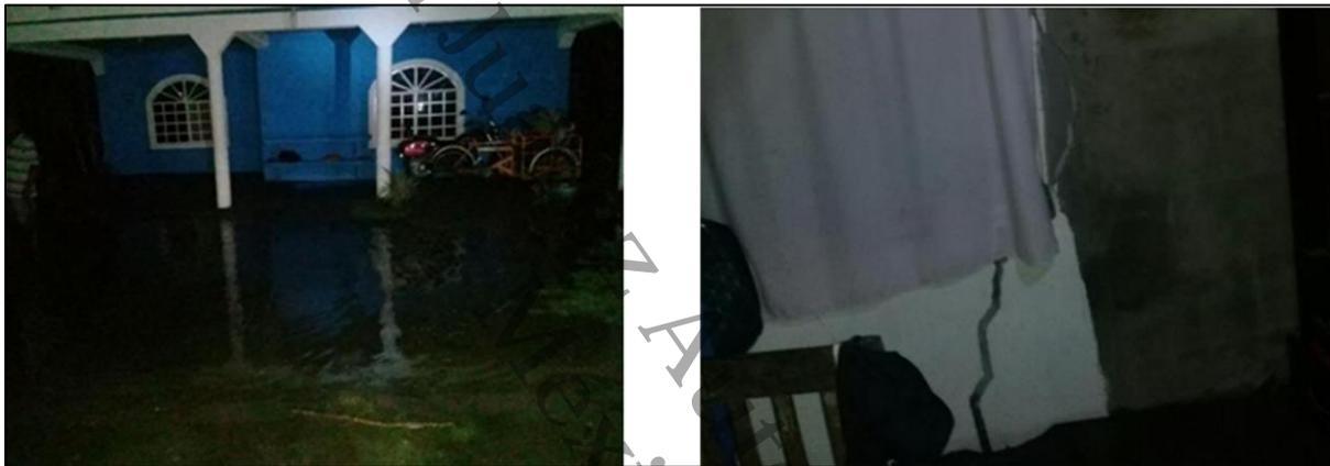
Figura 29. Hundimiento y fallamiento en una vivienda en Acachapan y Colmena (Jesús de la cruz et al., 2017).
