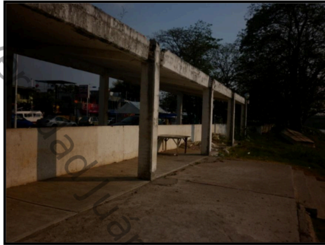
Fotografía 3.- Estación de pasajeros en la Terminal Cicom margen derecho.
