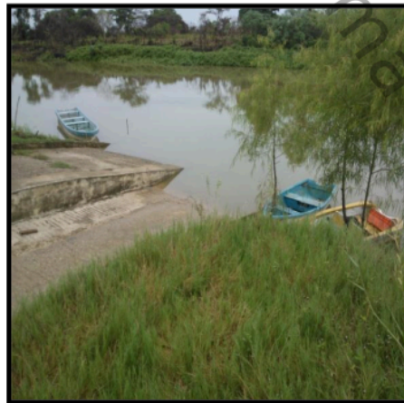
Fotografía 18- Muelle de Marina Zapote I.
