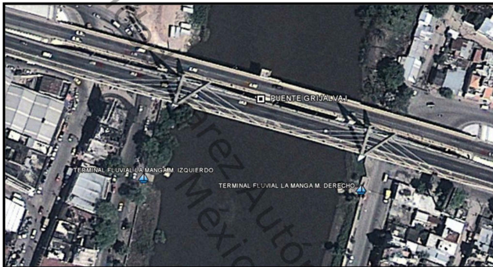
Figura 14.- Ubicación del Paso Fluvial La Manga margen derecho del río Grijalva.
