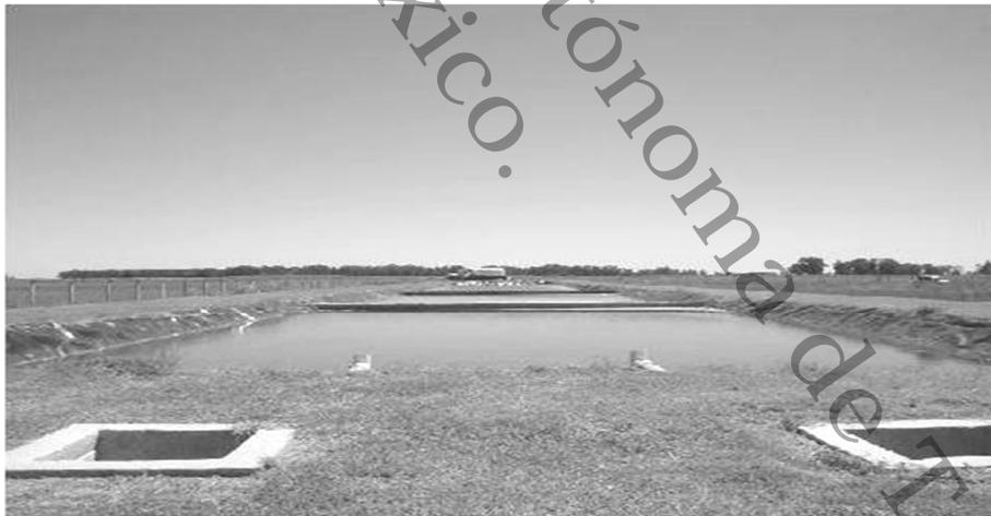
Figura 19. Planta de tratamiento a base de lagunas de estabilización.
