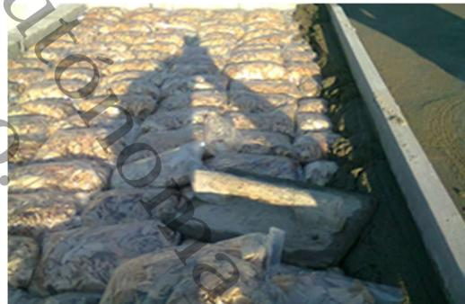
78.- Colocacion de la 3ra. Y 4ta. Capa (viruta encapsulada y mortero)
