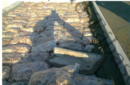
80.- Colocacion de la 3ra. Y 4ta. Capa (viruta encapsulada y mortero)
