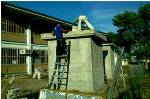
79.- Colocacion de la 3ra. Y 4ta. Capa (viruta encapsulada y mortero)
