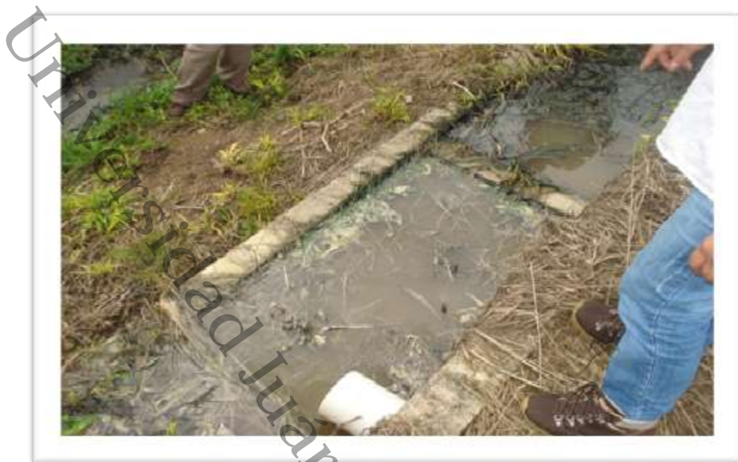
Descarga de agua residual de fumigación aledaña al aeródromo.
