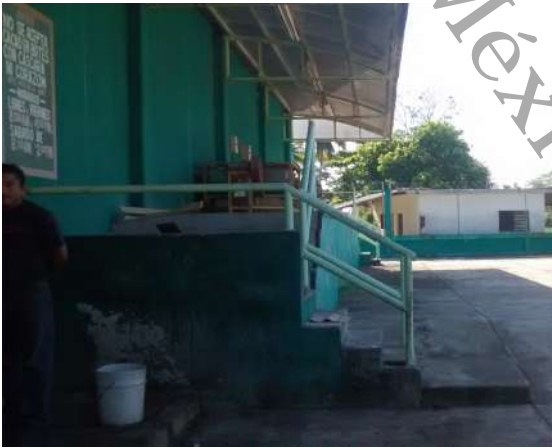
Figura.: Infraestructura: Ásoc. Agrícola Local Villa Aldama Comalcalco, Tabasco Fuente: Elaboración en base a la investigación
