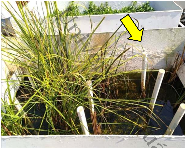
Figura 30. Zona sin vegetación en el HAFL debido a la mortandad de plantas.
