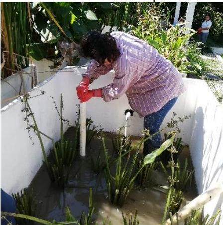
Figura A6 colocación de tubería de puntos de muestreo internos
