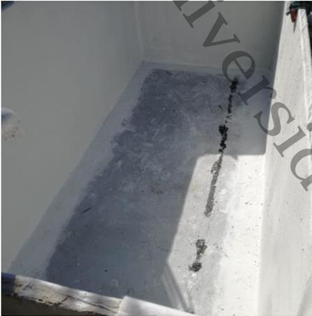
Figura A1. Preparación de los reactores con impermeabilizante y membrana de refuerzo
