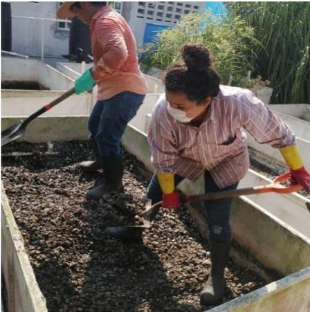
Figura A3. Llenado de los humedales con el medio de soporte
