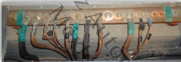
*Ilustración 25 Sistemas de puesta a tierra en telecomunicaciones*
