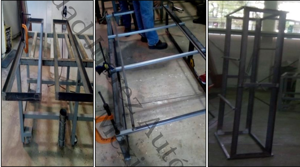
Figura 3.2 Estructura principal de la SC.
