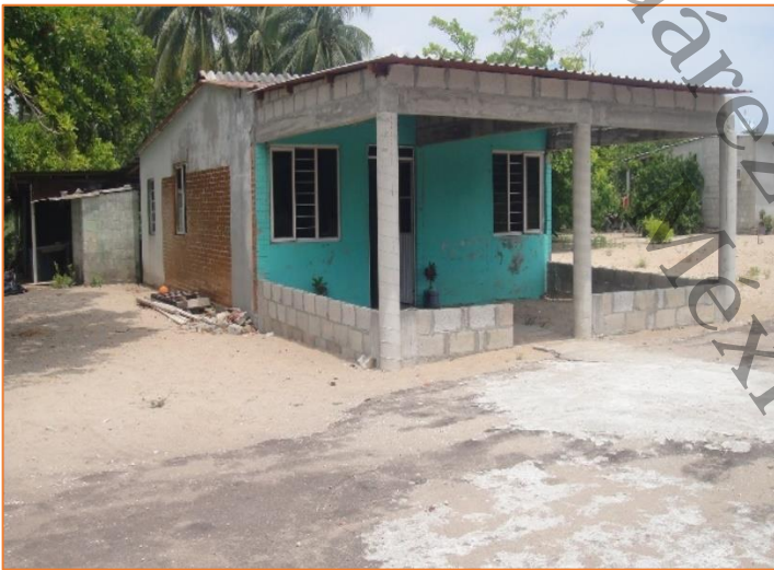
Vivienda de material con techo de lamina
