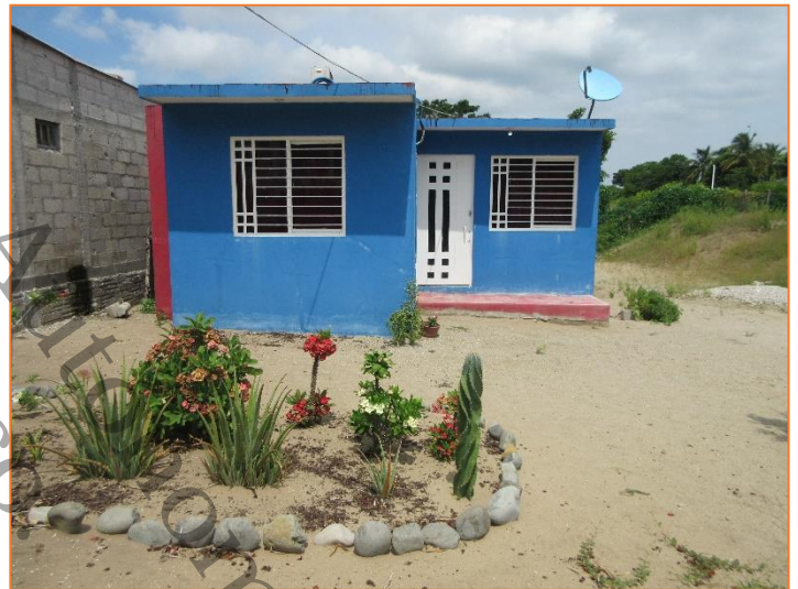
Vivienda de material y techo de material
