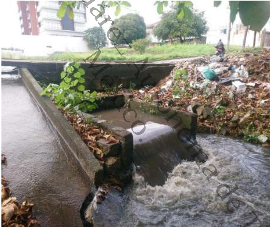
Descarga de aguas residuales y pluviales que se vierten a la ensenada Prados de Villahermosa de la laguna de Las Ilusiones.
