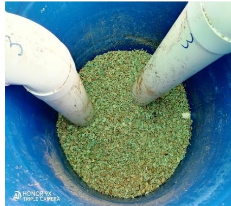
Figura 25. Colocación de material filtrante de gravilla, zeolita y arena para el primer sistema de filtración.
