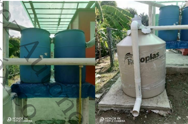
Figura 21. Colocación de tanques receptores y tanque de almacenamiento de agua.
