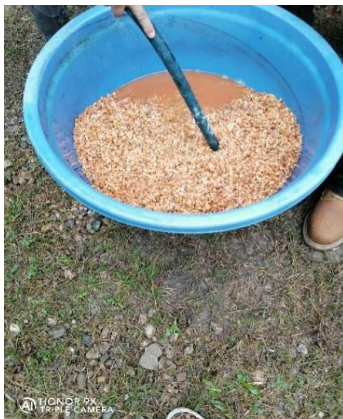
Figura 22. Lavado de los materiales filtrantes.
