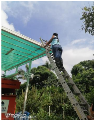
Figura 20. Mantenimiento de la techumbre.
