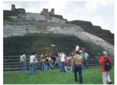
Jóvenes deteriorando la frágil estructura de este edificio, a pesar del aviso
