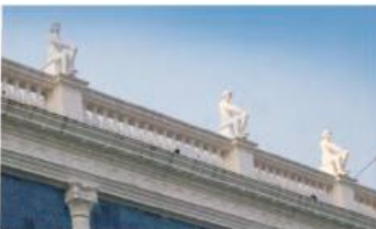
Detalle de la cornisa del inmueble catalogado como edificio histórico por el INAH
