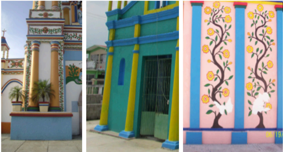
Figura 34, 35 y 36. Columnas adosadas en Cupilco y Tecoluta. Pilastras adosadas en Ayapa. Fuente: Propia, 2014.
