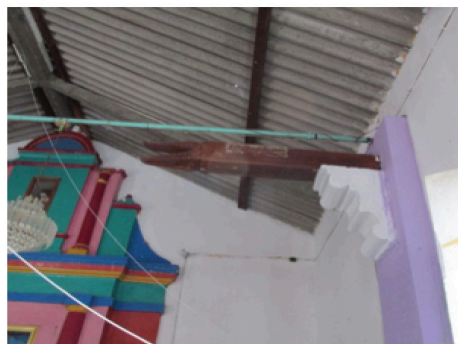
Figura 7. Viga con cabeza de lagarto en Tecoluta Fuente: propia 2015.
