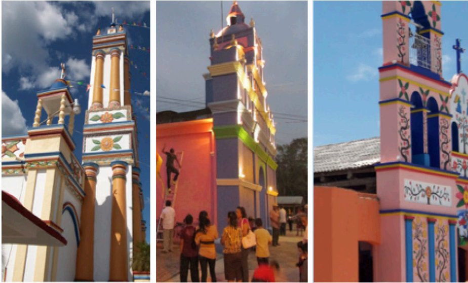
Figura 31, 32 y 33: Vista lateral de las fachadas de Cupilco, Huimango y Ayapa. Nótese las fachadas sobrepuestas sobre otra previa. Fuente. Propia, 2014
