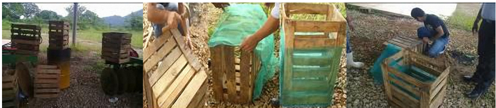
Figura 2. Construcción de contenedores.
