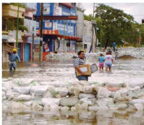
Muros de costales.
