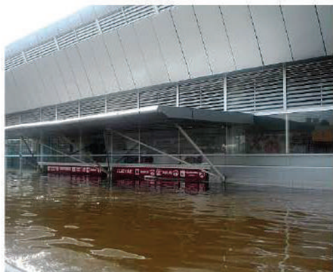
La terminal de autobuses ADO.
